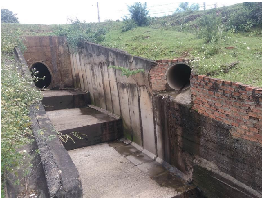
Apêndice 2.2.6.1.J. Canalização a céu aberto do córrego da Piedade e duto de água pluviais (à direita) (ponto 1).
