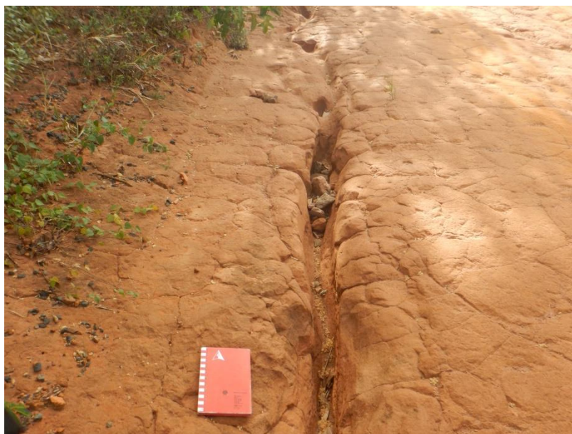
Apêndice 2.2.3.O. Feição erosiva em estrada no interior da FENP em área de ocorrência de Argissolo.
