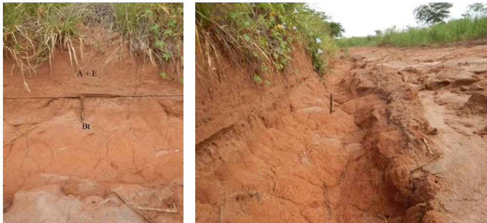
Apêndice 2.2.3.Q. Feição erosiva no entorno da FENP em área de ocorrência do Argissolo, evidenciando a diferença de estrutura ao longo do perfil.
